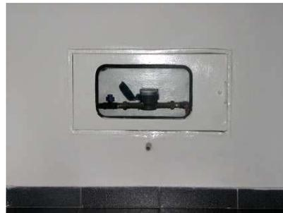
El aspecto de mayor importancia en lo que respecta a la tapa del medidor de agua, es la óptima visualización del contador. Bajo este principio se dictan las siguientes disposiciones acerca de la forma en la que puede ser modificada.
